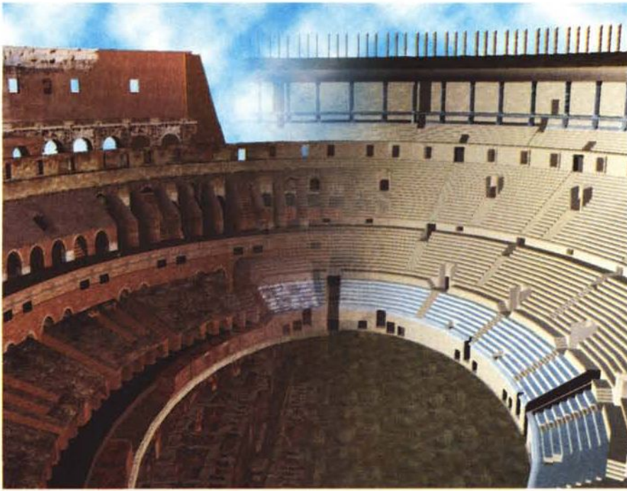
Foto 2a e 2b Impalcature e argani permisero di innalzare lo scheletro che venne poi tamponato con tufo e laterizio. Furono così costruiti gli anelli concentrici e i muri radiali su cui gravavano le volte degradanti in calcestruzzo che sostenevano la platea.
